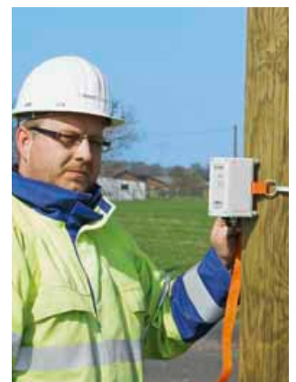
Heiko Wasser prüft mit einer neuen Methode die Standfestigkeit von Holzmasten.
