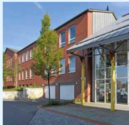
Ein Projekt der RWE ED in Hörstel im Münsterland: Eine zentrale „Wärmeinsel“ mit Blockheizkraftwerk versorgt Grundschule, Schwimmbad, Rathaus (Foto) und Turnhalle.
